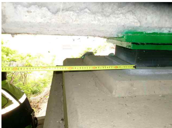
받침장치 연단거리 측정
