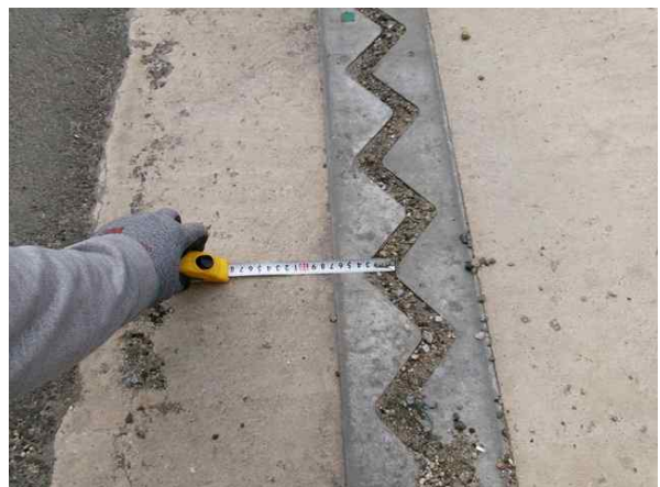
신축이음 이동량 측정
